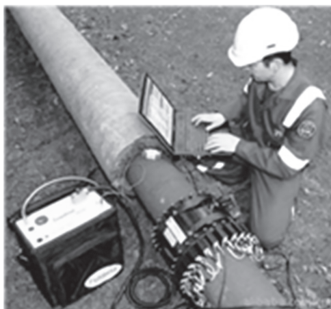
写真4 保温配管の検査
