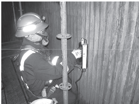
写真6 ボイラー水壁検査
