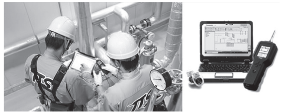
写真1 トラップ精密診断器と診断風景
