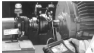
図14 ●レーザーアライメントによる作業イメージ
